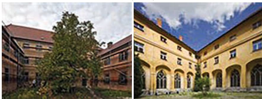
Obrázek č. 65 a 66 Vnitřní zahrada kláštera před a po rekonstrukci
