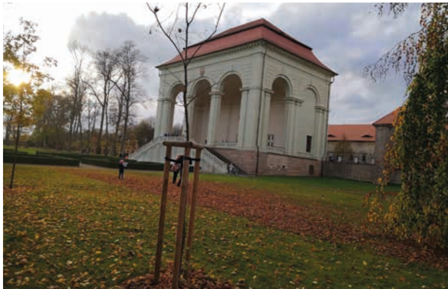
Obrázek č. 36 Valdštejnská lodžie: po I. etapě rekonstrukce
