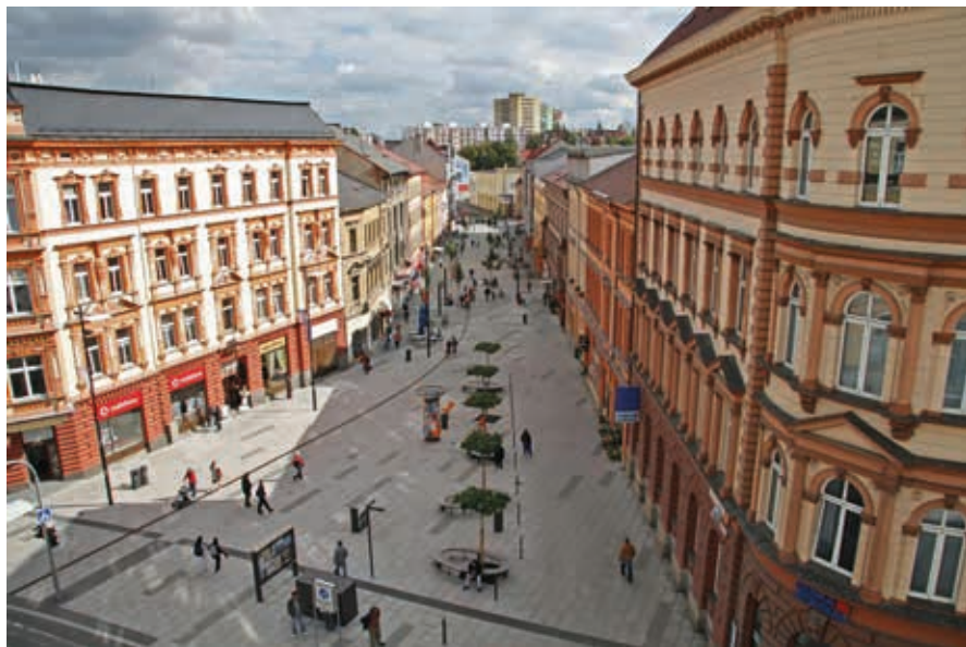
Obrázek č. 64 Pěší zóna v ulici Svobody v Chebu po rekonstrukci
