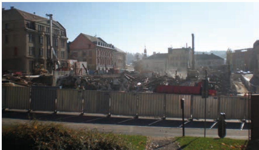
Obrázek č. 101 Západní část staveniště OC Central 2015, vlevo přehrazená Jugoslávská ulice
