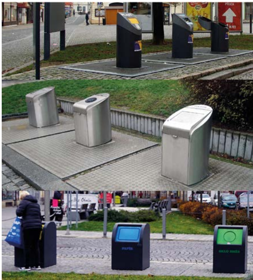
Obrázek č. 35 Příklady řešení odpadových nádob formou podzemních kontejnerů (Písek, Strakonice, Prostějov)
